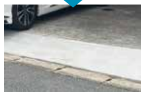
▲ブロック撤去後
