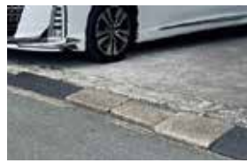
▲ブロック撤去前
