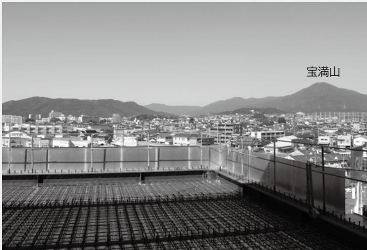
工事中の5階屋外テラス。鉄板と鉄筋を敷き詰めています。(3月6日撮影)
