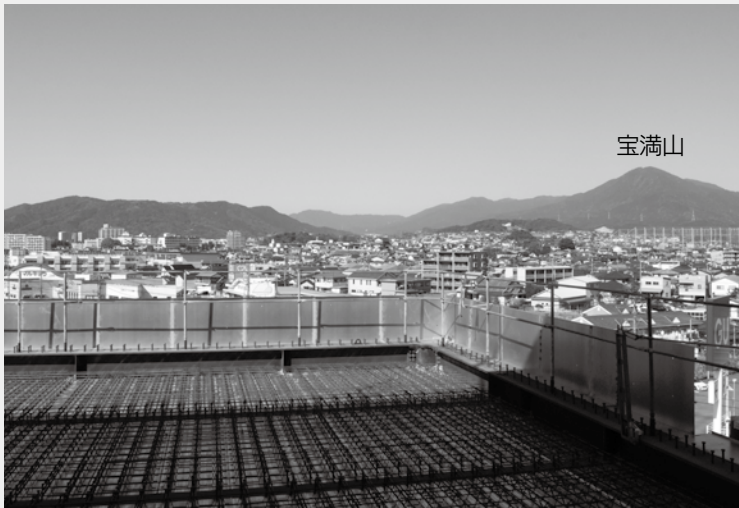
工事中の5階屋外テラス。鉄板と鉄筋を敷き詰めています。(3月6日撮影)
