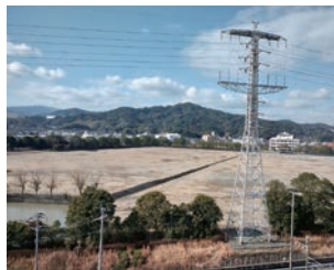
JT九州工場跡地
