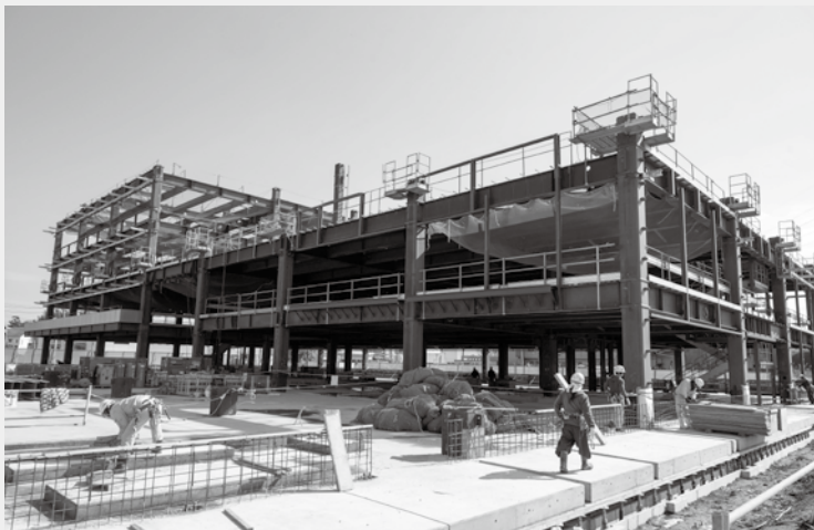
庁舎棟5階の床までの鉄骨工事を行っています。(J R鹿児島本線北側から2月9日撮影)
