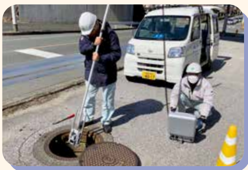
▲下水道の老朽管確認作業
