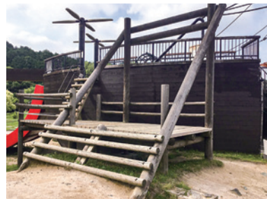
撤去されるデッキ
