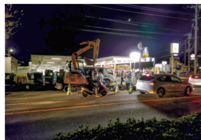
徹夜で行われる漏水工事
