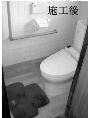
水洗化工事(施工後)
