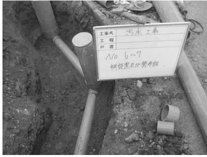
排水工事の様子
