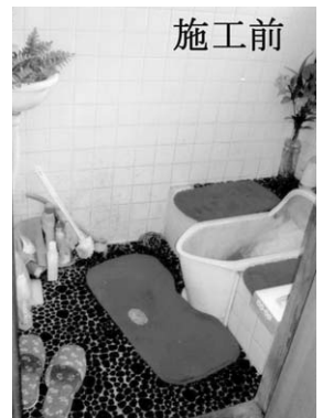
水洗化工事(施工前)
