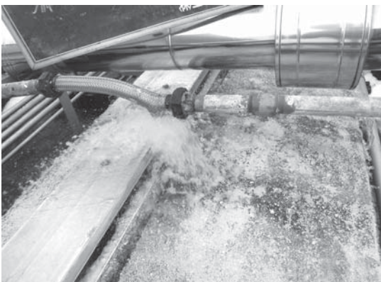
凍結により損傷し、激しく漏水する宅内給水管
