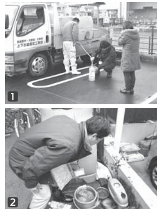
①給水車による給水 ②漏水を確認を行う市職員
