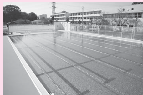
改築を行った筑紫小学校プール
