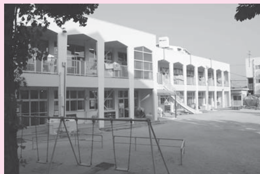
修繕が完了した二日市保育所
