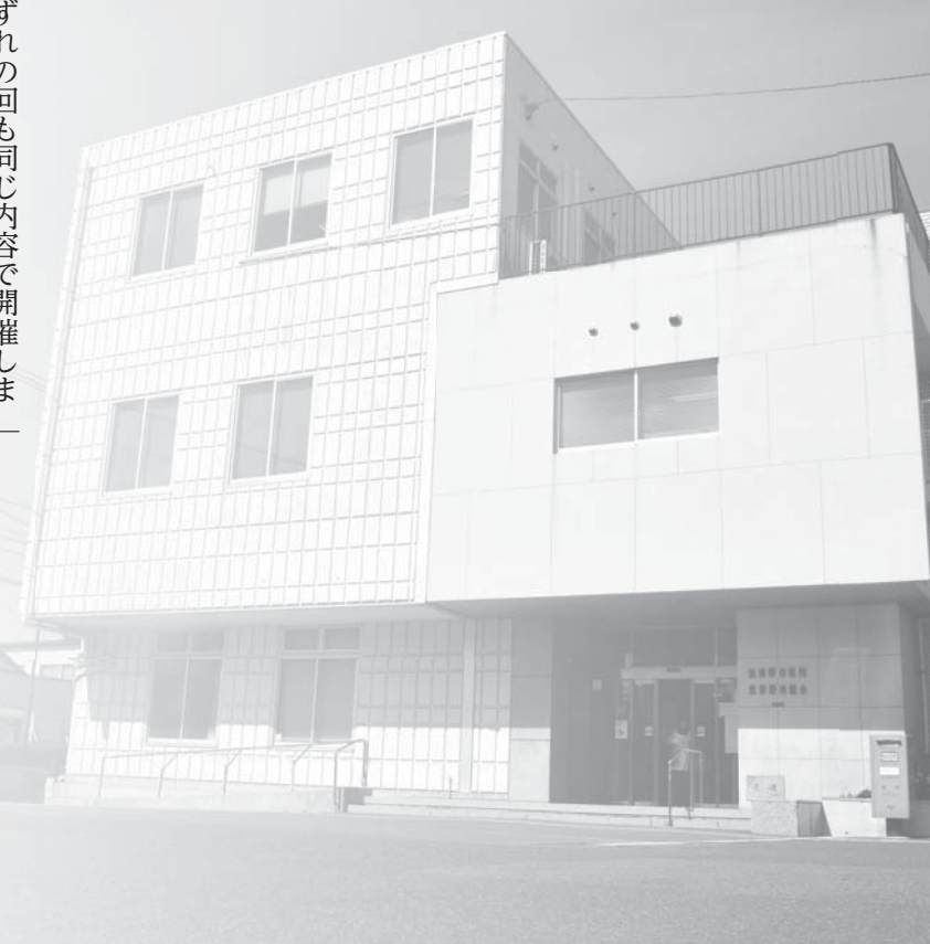
筑紫野市役所本庁舎本館
