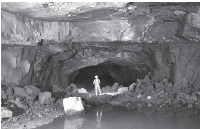
地下壕の内部(平成17年撮影)
