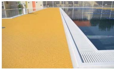
▲熱くなりやすく滑りにくいシートをプールサイドに設置しました。
