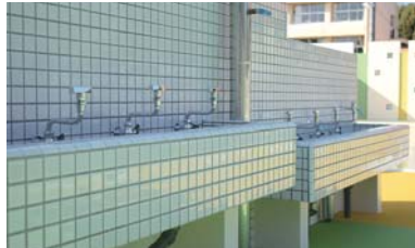
▲洗眼水栓も学年によって使いやすいよう高さを変えています。
