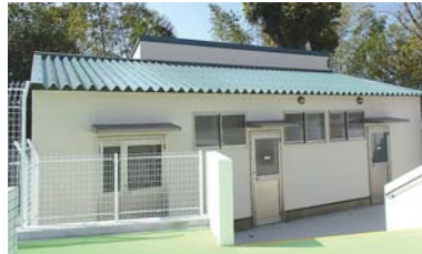
▲トイレと更衣室も改装を行いました。
