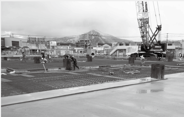
1階の床になるコンクリートを打設しています。(写真手前は打設済み) 1月11日撮影
