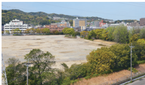
JT九州工場跡地
