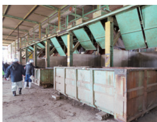
廃塗料が入ったコンテナ
