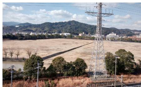
JT九州工場跡地
