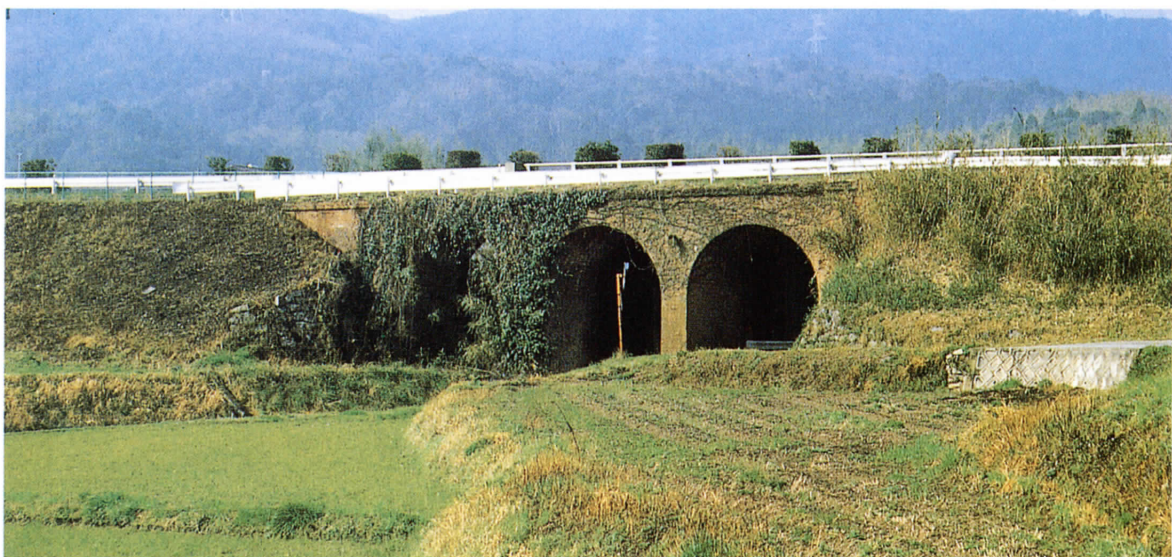
▲明治22年、ドイツ人技師の指導で建設された九州鉄道の「城山レンガ三連橋脚」今は筑紫野市道に利用されている
