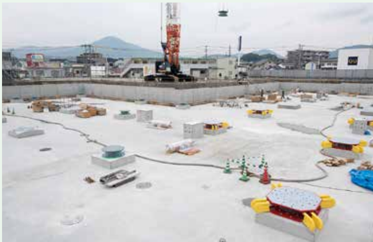
コンクリートの土台の上に免震装置を設置しました
