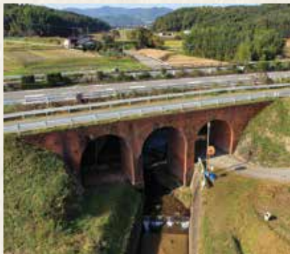
旧九州鉄道城山三連橋りょうの近景
