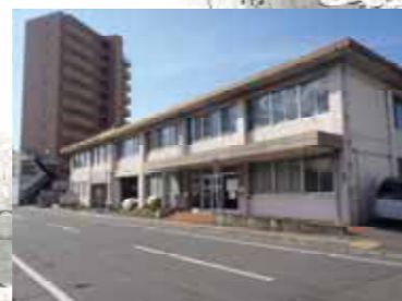
上下水道庁舎
