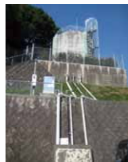
筑紫野団地配水池
