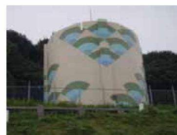
天拝坂低区配水池
