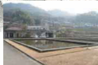
山口浄水場 山口配水池
