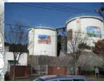
原田ニュータウン配水池
