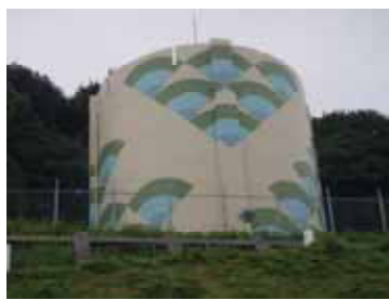
天拝坂低区配水池
