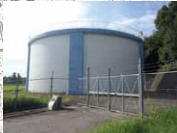
阿志岐配水池
