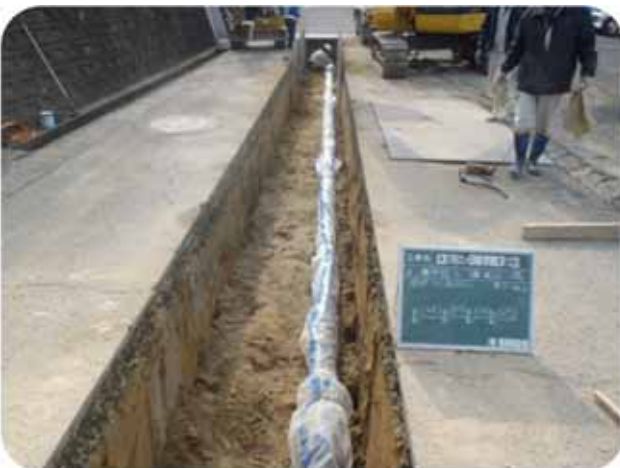
老朽管の更新工事（むさしヶ丘）
