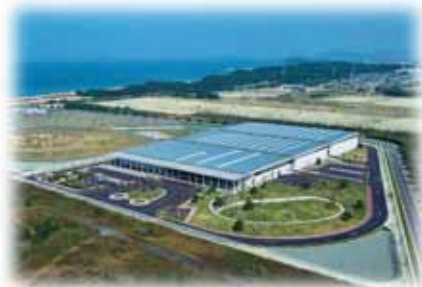
海水淡水化センター（福岡地区水道企業団）
