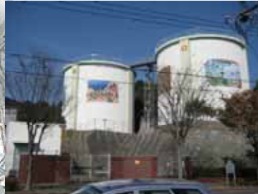
原田ニュータウン配水池
