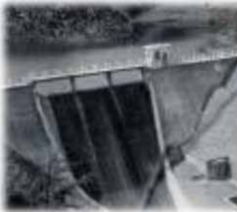
水呑ダム（創設時）
