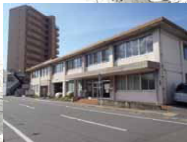
上下水道庁舎
