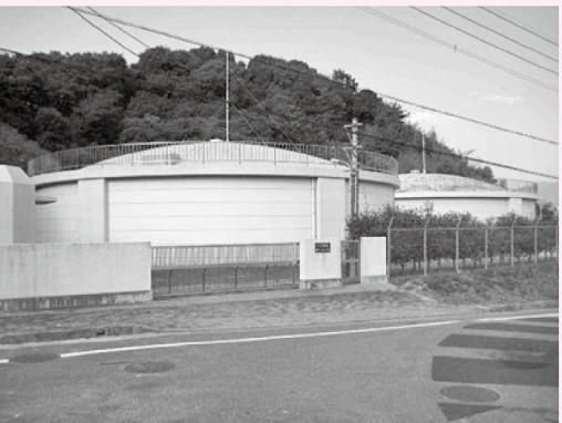
天拝坂中央配水池
