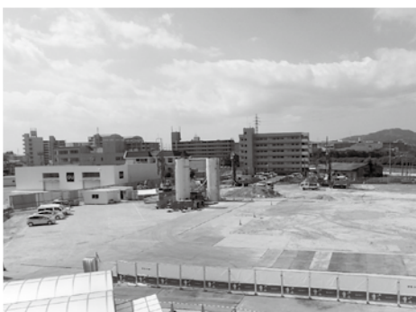
地盤改良工事を行っています
