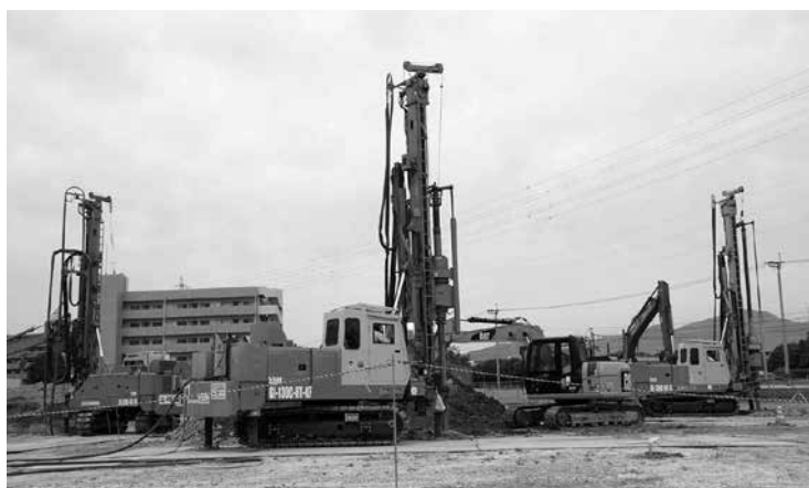
地盤改良工事の様子
