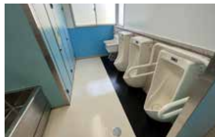
▲改修した山口小学校のトイレ
