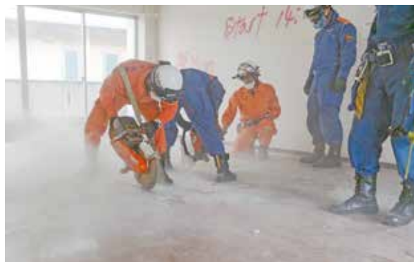
コンクリートカッターを使った階下への破壊進入訓練
