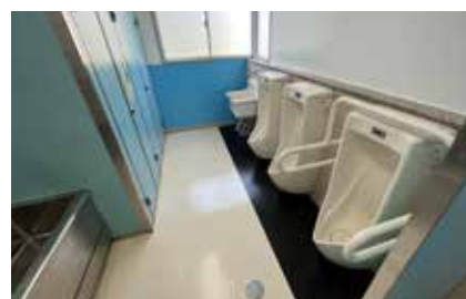
▲改修した山口小学校のトイレ
