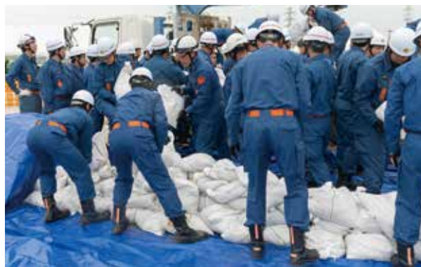
消防団による河川決壊時の水防築堤訓練
