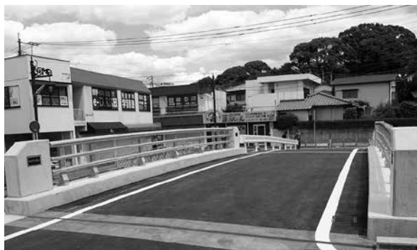
高尾川の改修に伴い、平成29年9月には平成橋が完成
