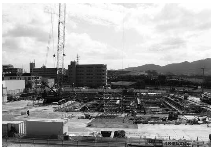
平成30年11月末の完成を目指して市庁舎を建設中です
