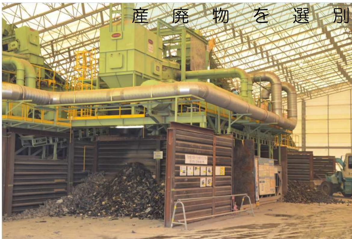
滋賀県栗東市小野地区 安定型産業廃棄物最終処分場対策事業
