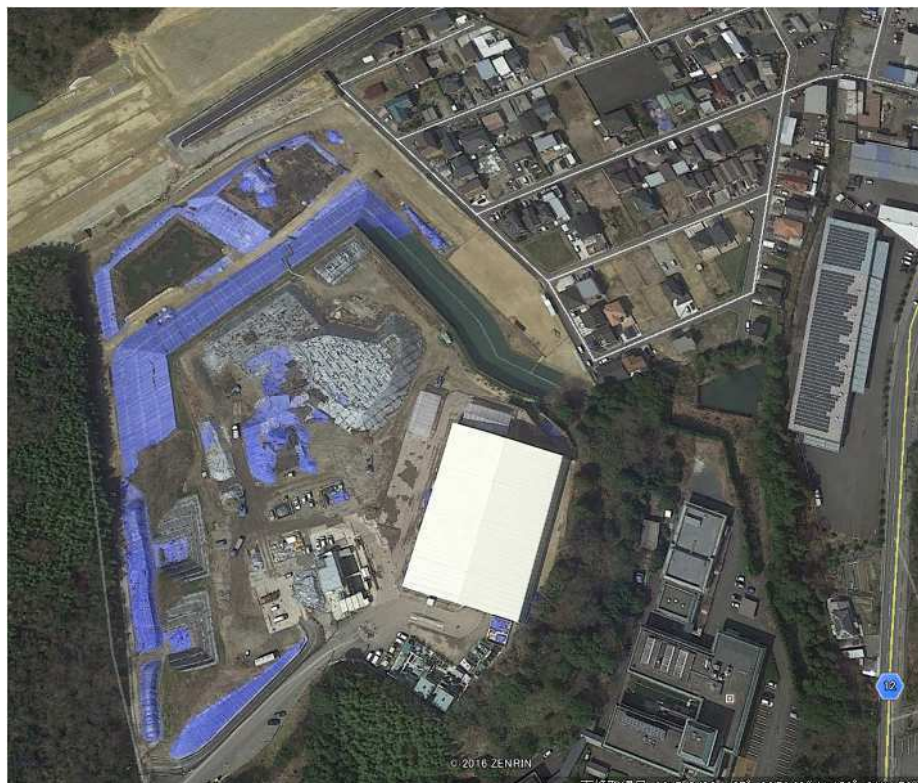
滋賀県栗東市小野地区 安定型産業廃棄物最終処分場対策事業
