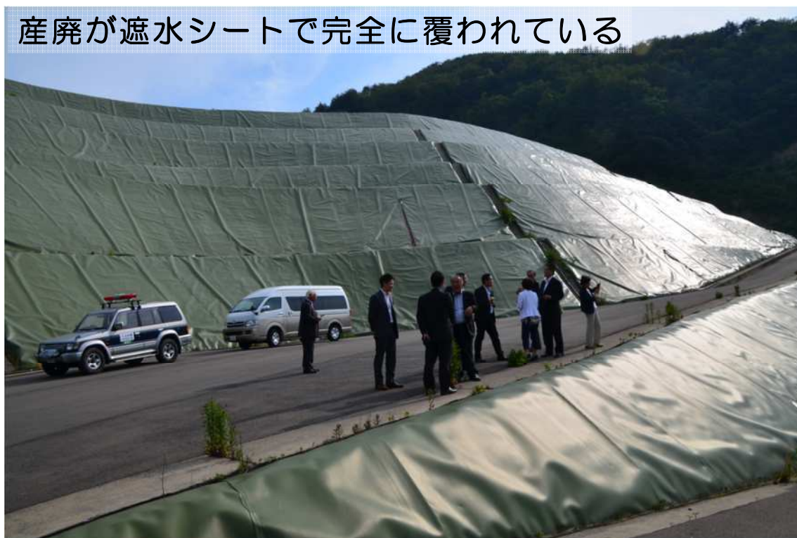
福井県敦賀市檜曲地区 管理型産業廃棄物最終処分場対策事業
