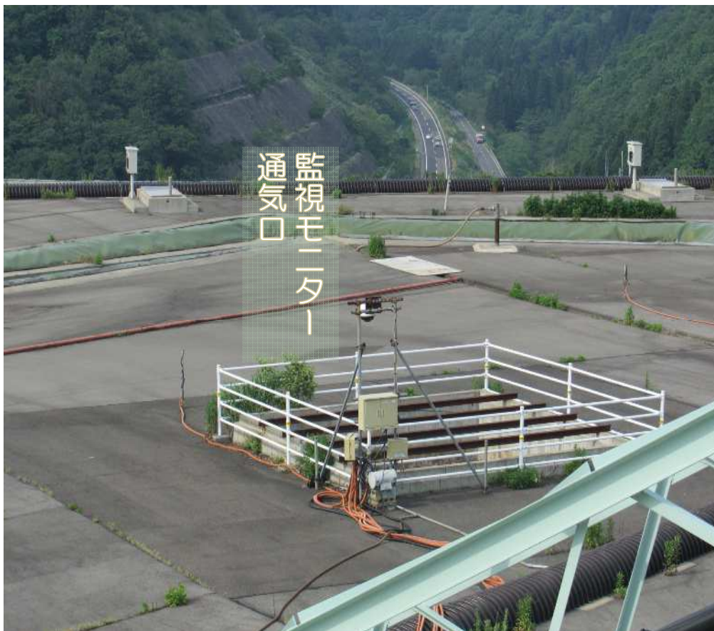
福井県敦賀市檜曲地区 管理型産業廃棄物最終処分場対策事業
