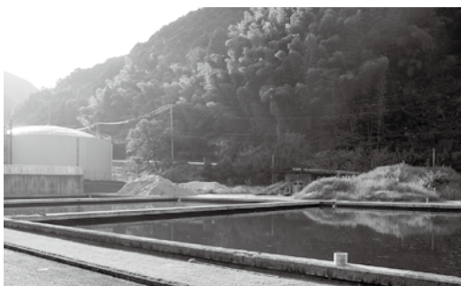
山口浄水場 (大字山口2066)
