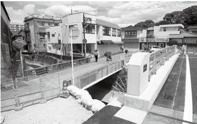
水道橋(左)と完成した平成橋(右)
