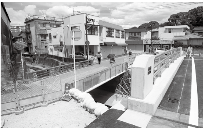
水道橋(左)と完成した平成橋(右)
