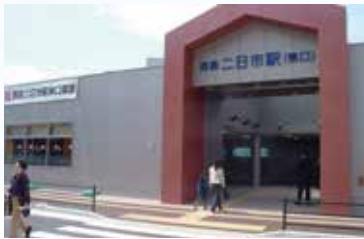
●平成15年 西鉄二日市駅東口が開設
