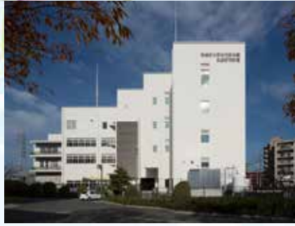
● 平成27年 筑紫野太宰府消防組合消防本部筑紫野消防署落成
