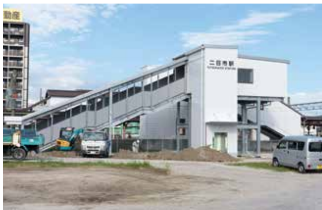
▲着々と工事が進むJR二日市駅西側乗降口
