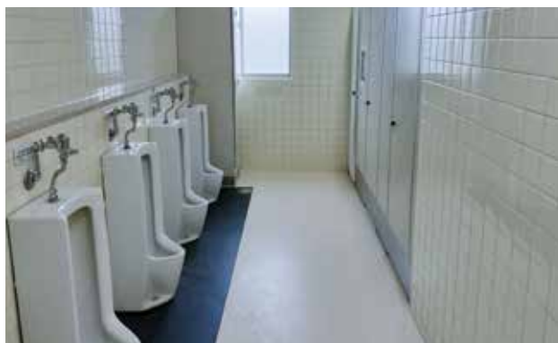
▲改修されたトイレ(二日市東小学校)
