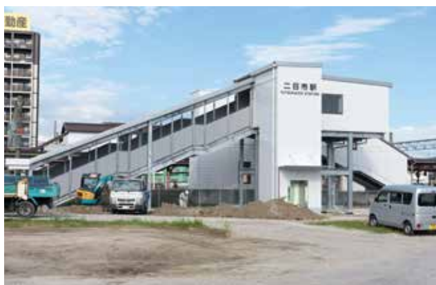
▲着々と工事が進むJR二日市駅西側乗降口
