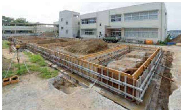
▲基礎部分をつくる工事をしています
