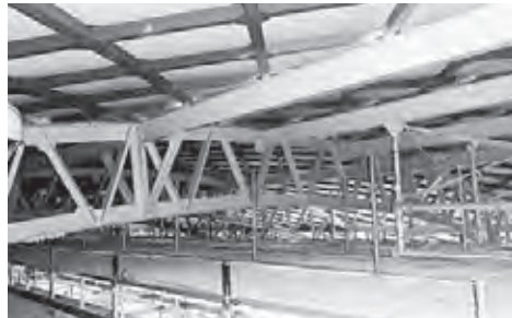
落下防止対策工事中の屋内運動場
