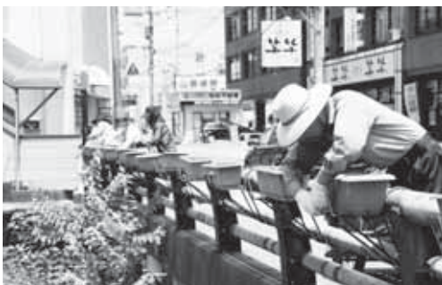
橋口橋のプランターの土の入替と補修を行いました
