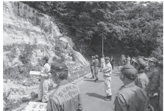
水防協議会の調査の様子
