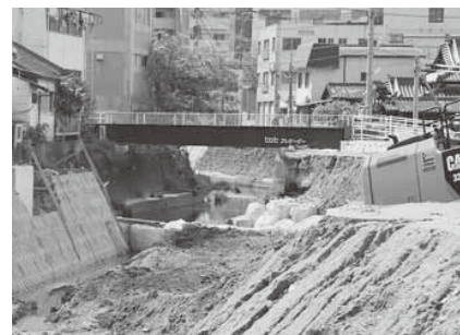
川幅調整のための護岸工事
