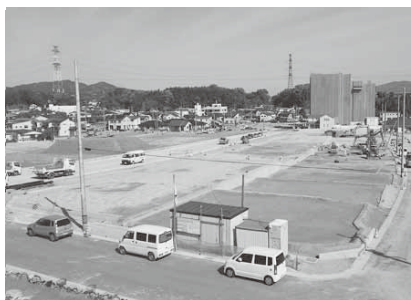
宅地をつくっています
