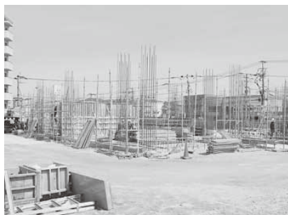
建築が進む、二日市東コミュニティセンター
