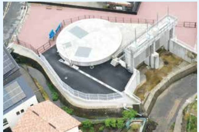
▲整備された流入立坑
