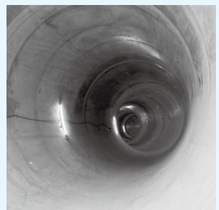
▲地下河川内部
