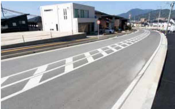
▲土地区画整理事業の進捗により開通した筑紫原田線
