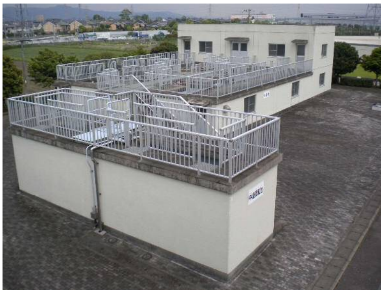
常松浄水場（ろ過池・中塩混和池）
