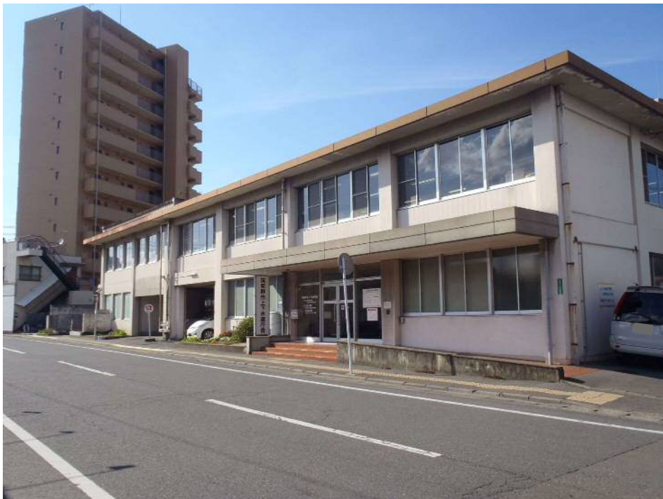
筑紫野市上下水道庁舎
