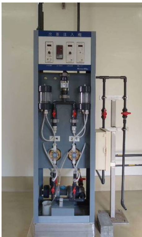
← 次亜塩素素注入機（原田ニュータウン配水池） 山神水道企業団から受水している浄水の残留塩素濃度を測定し、必要に応じて、次亜塩素酸ソーダを追加しています。
