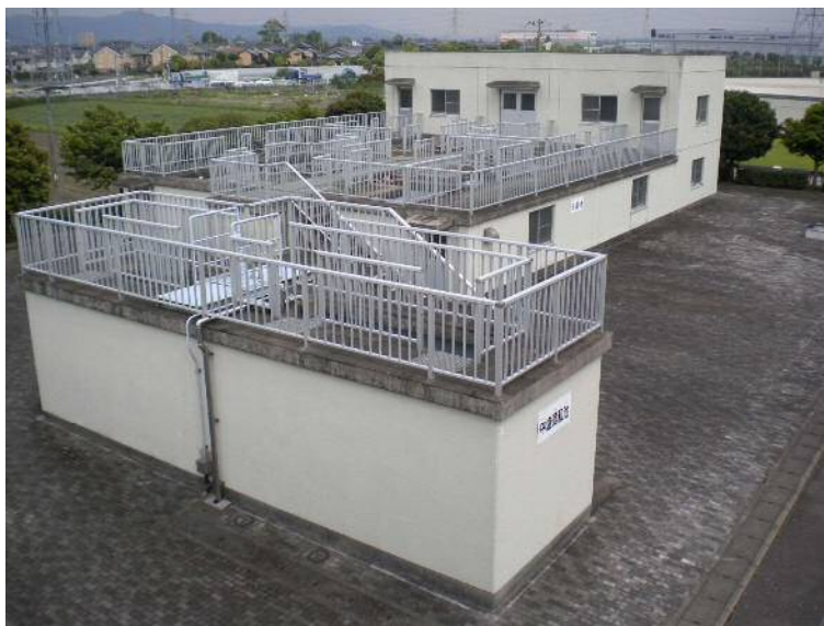
常松浄水場（ろ過池・中塩混和池）
