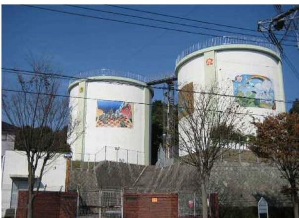
←原田ニュータウン配水池
