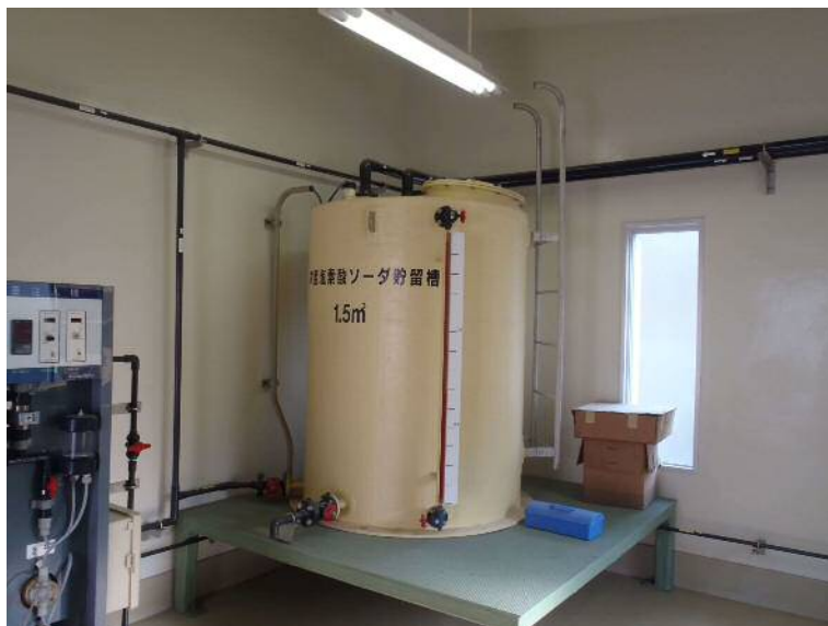
次亜塩素酸ソーダ貯留槽 → （天拝坂中央配水池）
