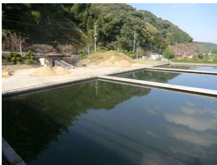
山口浄水場 緩速ろ過池（1970年供用開始）
