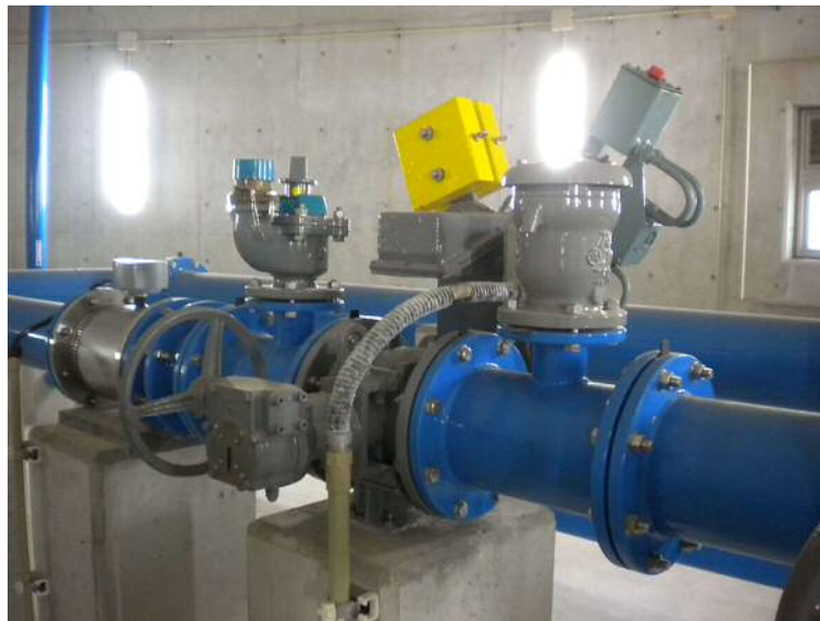
緊急遮断弁（原配水池）
