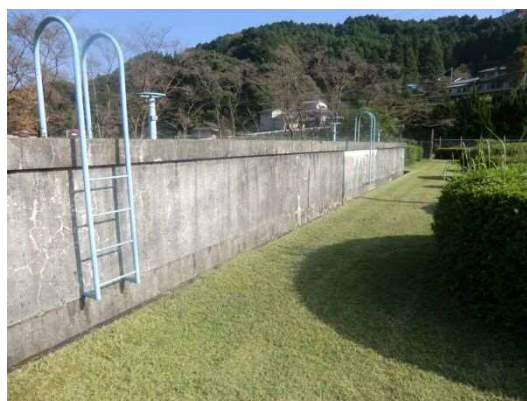
山口配水池（1970年供用開始）
