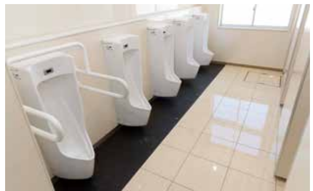
▲トイレの改修を進めています
