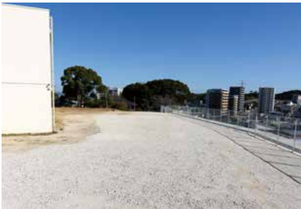
▲斜面の整備により拡幅した学校敷地
