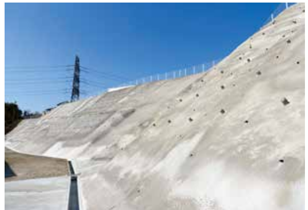
▲崩壊防止措置を行い、固定された筑紫小南側の斜面
