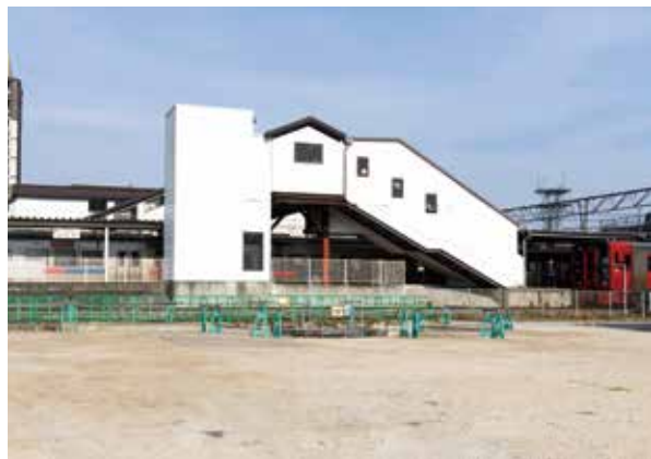
▲既存の通路に西側乗降口を新設します
