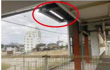
跨線橋の補強工事箇所
