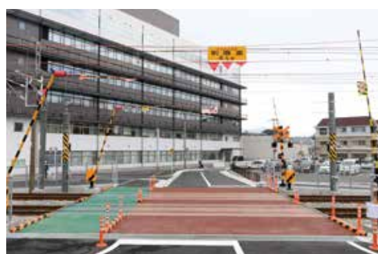
市役所南側、JR線踏切の改良により自動車の通行が可能に
